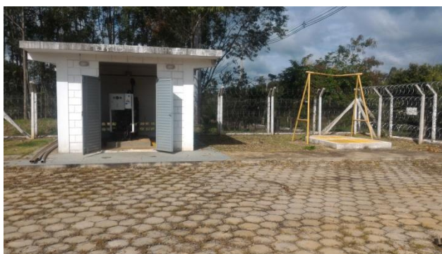
Foto 3.12 – Estação Elevatória de Esgoto
