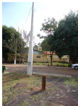
Foto 3.9 – Poço recentemente perfurado
