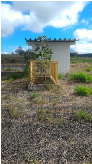
Foto 3.19 – Tanque de contato
