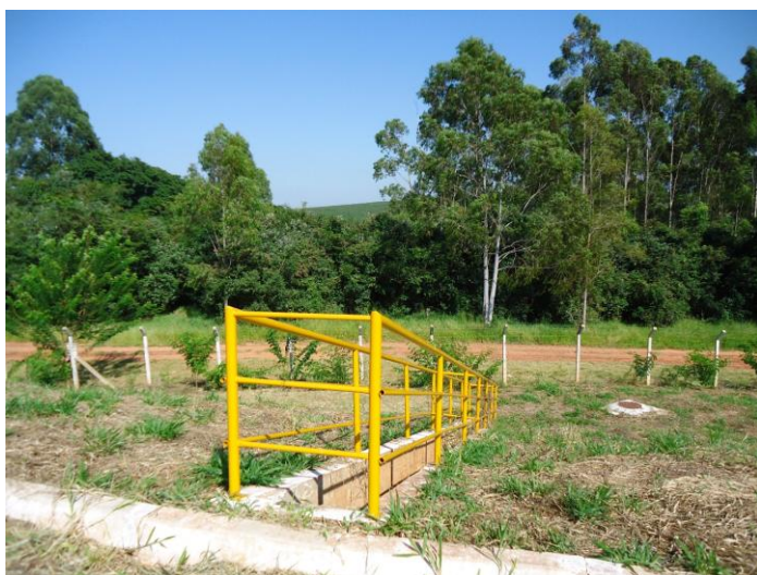
Foto 3.13 – Grades de proteção na chegada do esgoto
