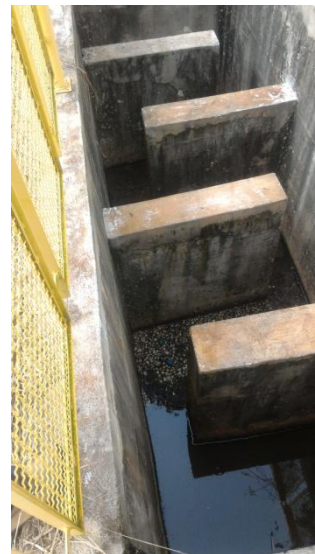
Foto 3.20 – Interior do tanque de contato
